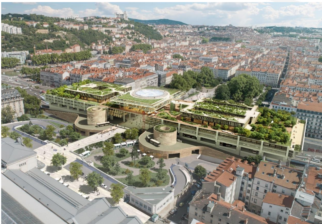
Vue aérienne sud-est depuis la gare de Lyon-Perrache ©Dietmar Feichtinger Architectes / IDA+
